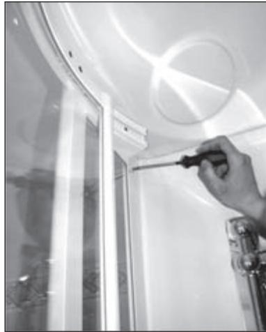
14. Do „U“ profilů vyvrtat otvory vrtákem prům. 2,5 mm na čtyřech místech, dveře se zajistí čtyřmi šrouby 3,5x13mm, šrouby se zakryjí čtyřmi krytkami.
