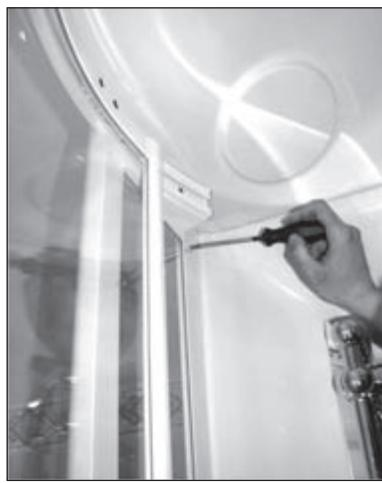
15. Zasunout box do místa jeho ukotvení, ryskou označit dosah stěny od rohu koupelny viz obr.
