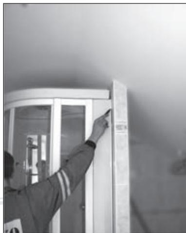
16. Na stěnu koupelny 15 mm od rysky se přiloží konzola a označí se její otvory pro následné vyvrtání viz. obr.
