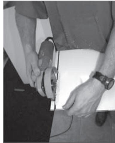
26. Uřezání vodicí lišty na výšku krycího panelu.
