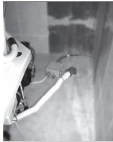
19. Zapojení přívodních flexi hadic 1/2" F.
