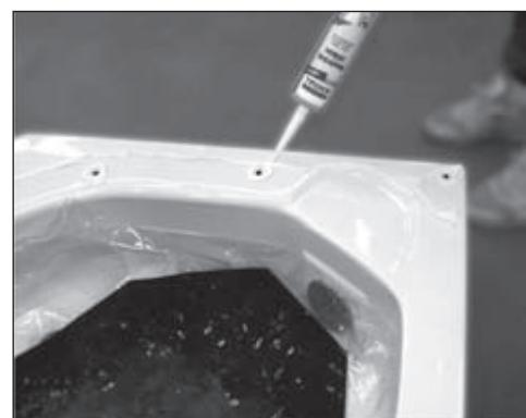
7. Kontrola dotažení stahovacích oček nástrčným klíčem 7 mm, odmaštění spodní dosedací plochy středního dílu, zajištění kabeláže.
