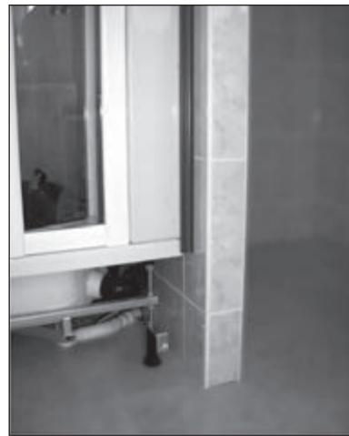
22. Označení osmi bodů pro uchycení vodící lišty (předem uřezané) na míru a čtyř míst ukotovacích šroubů na bočním lemu stěny. Výrezání čtverce do vodící lišty pro ukotovací šruby viz. obr.
