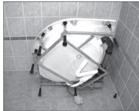
6. Vložení ochranné podložky do vaničky, zdrsnění zadní dotykové části na vaničce smirkovým špalíkem, odmaštění plochy prostředkem na bázi alkoholu, rovnoměrné nanesení vrstvy těsnícího tmelu viz. obr.
