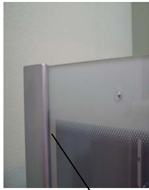
Utěsnit těsněním seal
