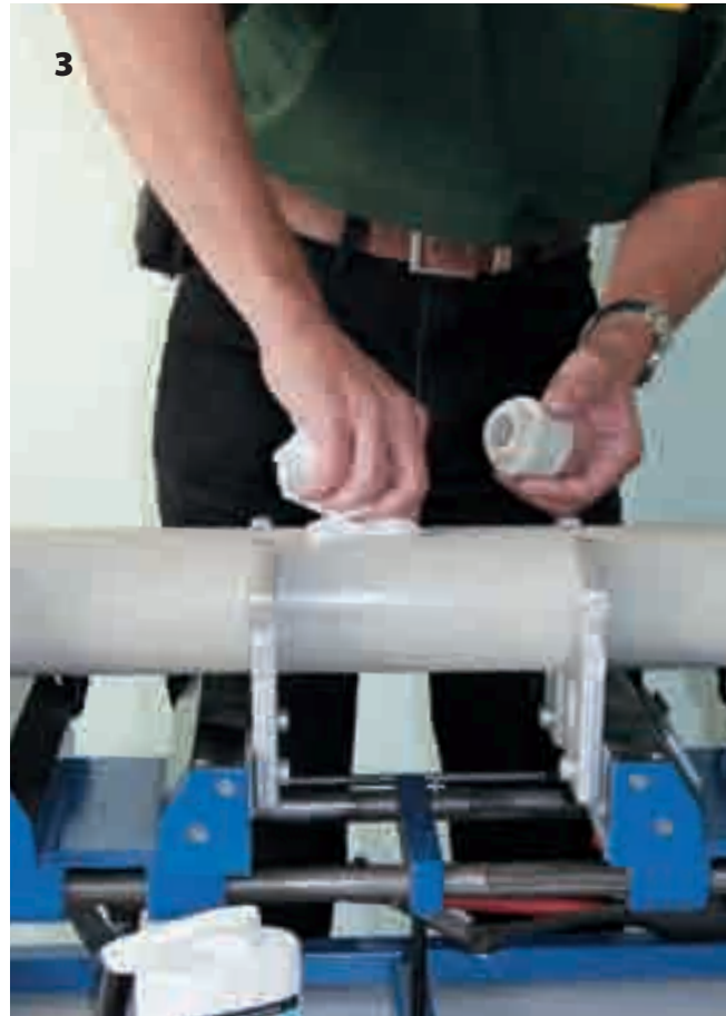
Začistíme. Pokud používáme trubku STABI, u vyvrtaného otvoru srazíme hranu. Očistíme a odmastíme tvarovku i vyvrtaný otvor.
