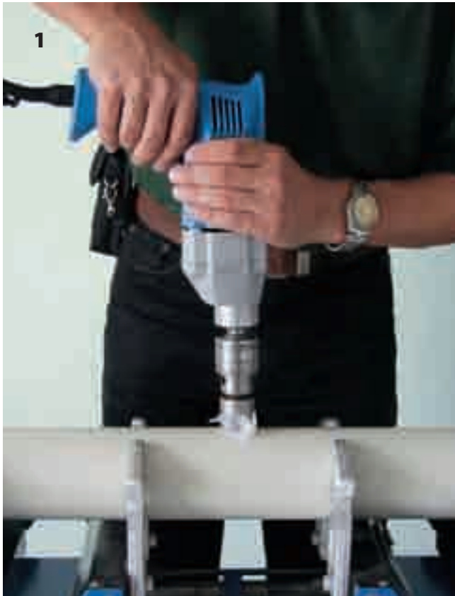
Speciálním vrtákem vyvrtáme otvor pro potrubí.
