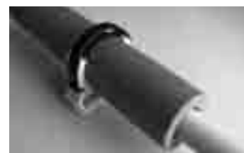
U teplé vody se objímka instaluje přes izolaci o dimenzi větší
