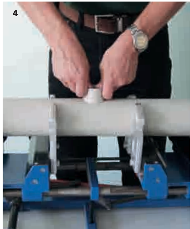
Nahřáté sedlo nasuneme do nahřátého otvoru a fixujeme cca. 16 s. Po uplynutí jedné hodiny lze napustit vodou a namáhat tlakem.
